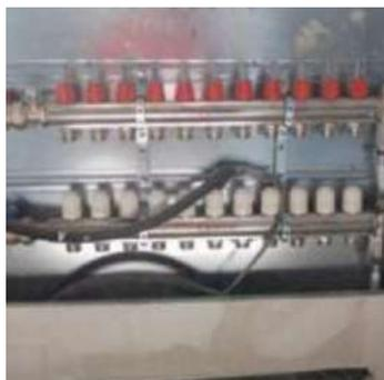
Installare la cassetta nelle posizioni prestabilite dal disegno e fissare il collettore al suo interno.
