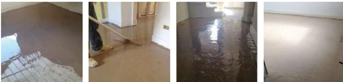
Dopo 48 ore si può stendere il riempimento ed effettuare il livellamento in spessore minimo di 5 mm sopra bugnia. Lo spessore massimo del massetto realizzabile è 15 mm.
